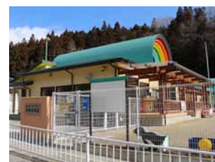
2013年3月、竹駒保育園は陸前高田市の公共の建物で震災後初となる仮設ではない建物として完成した
