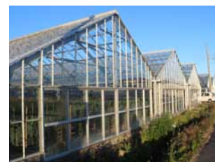
被災時は骨組みだけ、泥とガレキに埋もれていたハウスも助成で再建
