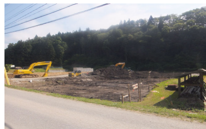
(造成中の新施設建設予定地)
