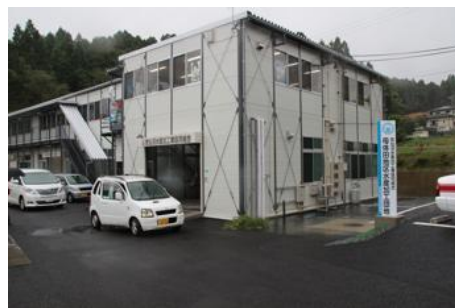
母体田地区水産加工団地内敷地をアスファルトで舗装整備
