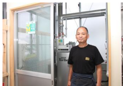
施設設備例／ ボイラー室を設置
