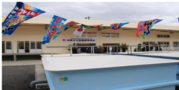
完成したカキ処理場 (鉄骨平屋建て508㎡、敷地3,069㎡)
