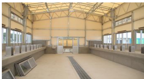
冷蔵庫やカキむきの作業施設が完備している作業場
