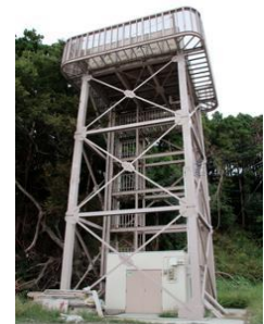
塩水取水塔も復旧
