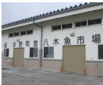
再建した町営魚市場
