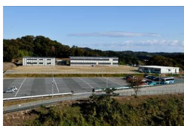
(建設された仮設施設全景)
