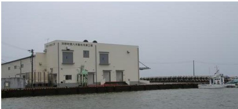
竣工の製氷・貯氷施設(環境に配慮したノンフロン化や機械室は2階の津波対策も)
